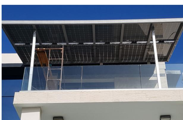
Fast 160 kWh Strom täglich liefert die große, mit transparenten M60 Modulen bestückte Terrassenanlage, die hoch über dem Mittelmeer in einem Vorort von Tanger im Sommer installiert und im November erweitert wurde. Wenn die Sonne richtig scheint, wird die installierte Leistung deutlich übertroffen, verursacht durch das indirekte Licht, das vom Meer reflektiert wird.
